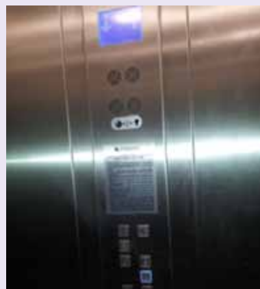
2. Wnętrze windy z tablicą sterującą - na dole widoczny wyraźnie oznakowany alarmowy przycisk przywoławczy
