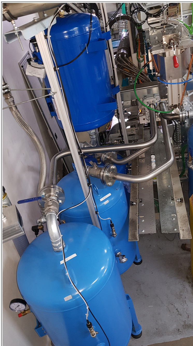
Foto 1: Instalacja układu rozdmuchu powietrza.
