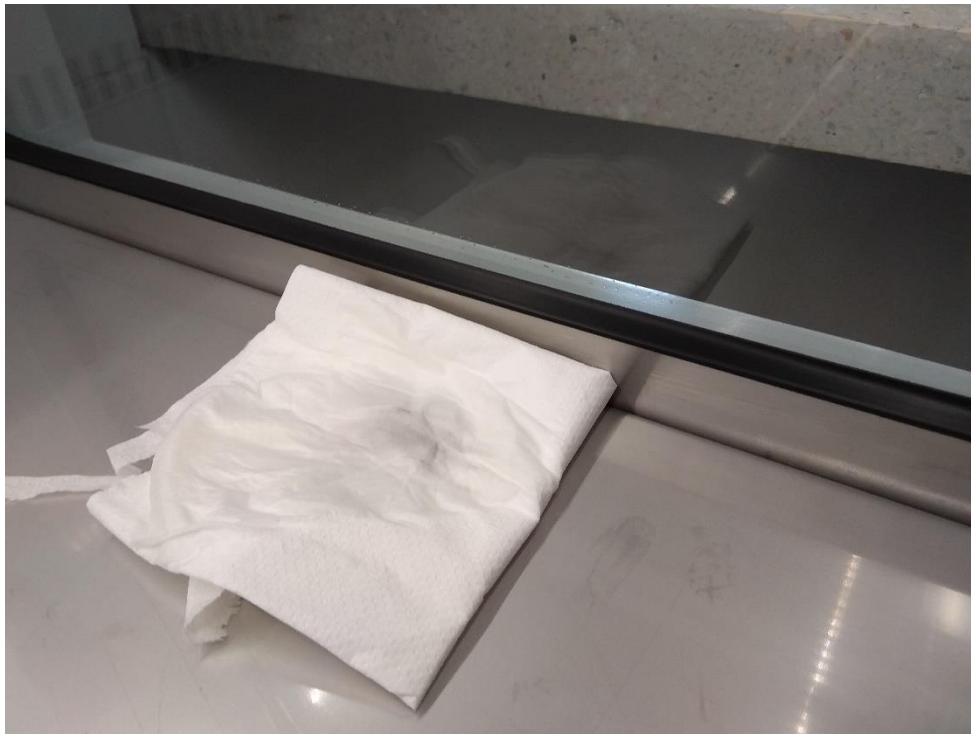
Fot. 5 Ślady na papierze po czyszczeniu uszczelki w ścianie bocznej
