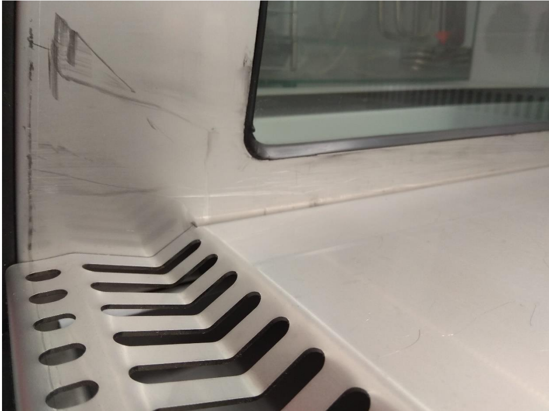
Fot. 1 Zarysowane elementy obudowy przez blat roboczy
