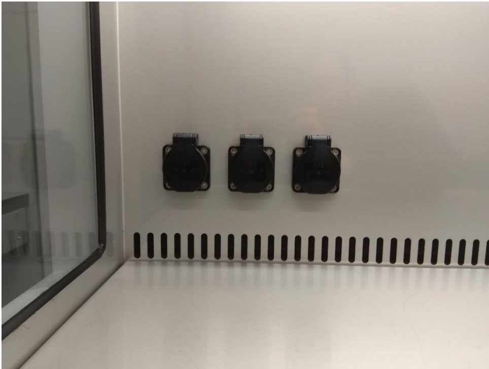
Fot. 2 Umieszczenie gniazd zasilających
