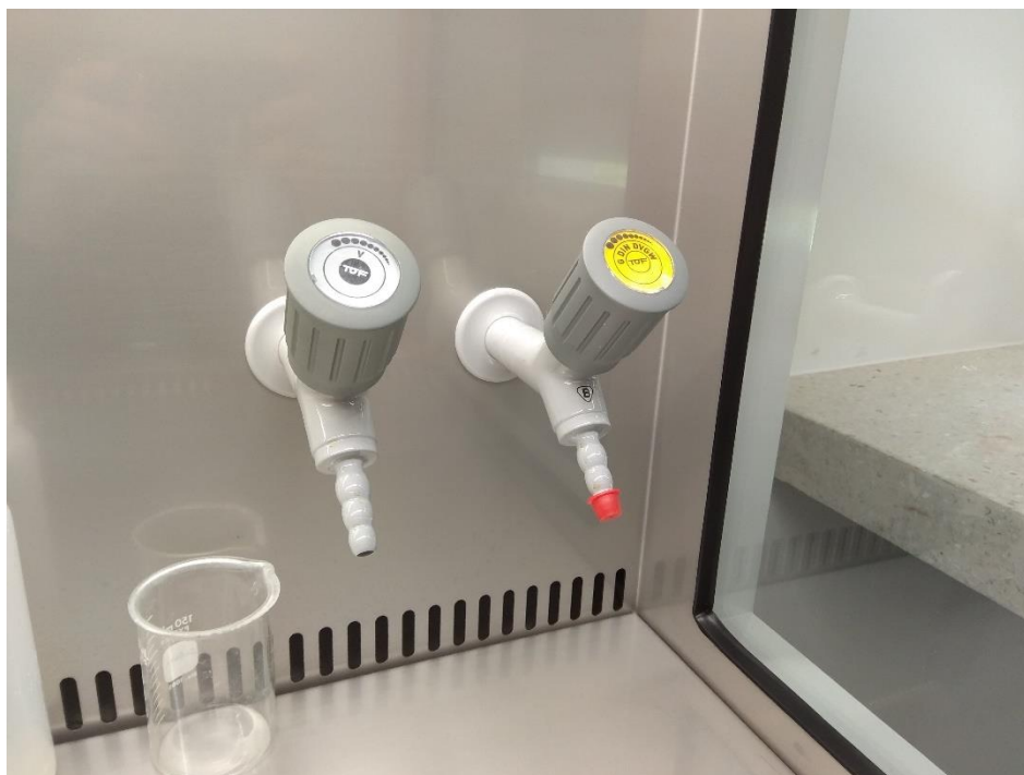
Fot. 3 Kran doprowadzający gaz zabezpieczony odpowiednią zaślepką (po prawej)
