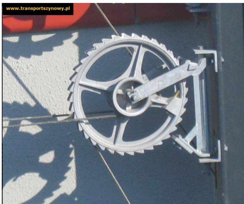
Rysunek 57. Możliwe rozwiązania. Napinacze ciężarowe z przełożeniem 1:3, Źródło: Kotwienie i napreżanie sieci jezdnych - transportzynowy.pl
