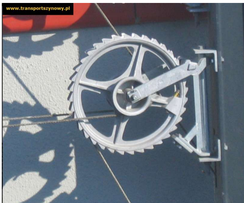
Rysunek 57. Możliwe rozwiązania. Napinacze ciężarowe z przełożeniem 1:3, Źródło: Kotwienie i napreżanie sieci jezdnych - transportszynowy.pl
